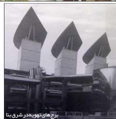
برج های تهویه در شرق بنا
