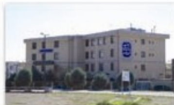
پروژه اداره کل نوسازی مدارس استان قزوین
